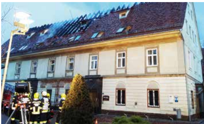
Das Feuer richtete große Schäden an der Hofer Mühle an.
